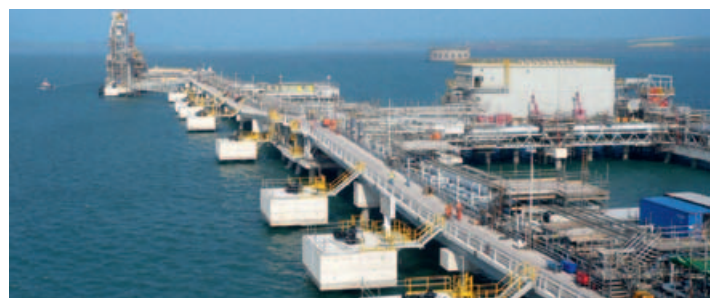
In Milford Haven (Wales) wird verflüssigtes Erdgas wieder in seinen gasförmigen Aggregatzustand gebracht und in das britische Netz gespeist. Bis zu 20 Prozent des britischen Bedarfs können so gedeckt werden.
