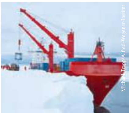
3.500 Tonnen Material für die Forschungsstation werden an der Schelfeiskante entladen.
