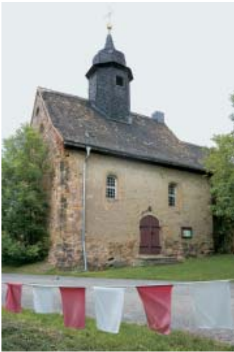
Bis hierhin und nicht weiter – hinter der Kirche arbeitet schon der Abrißbagger
