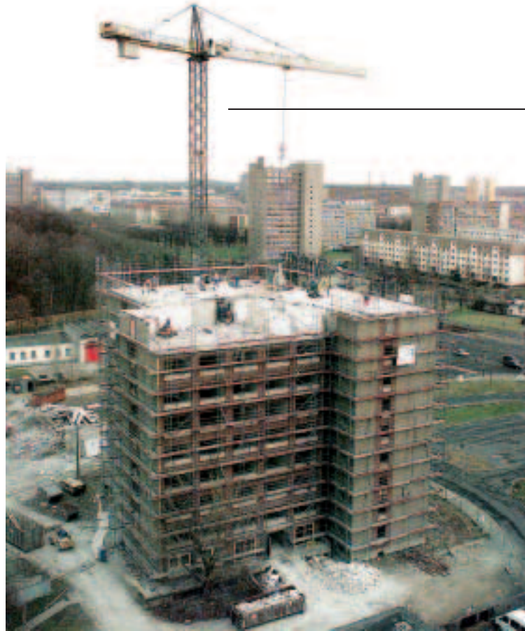
7 Rückbau eines Plattenbaus in Leipzig-Grünau 2004
