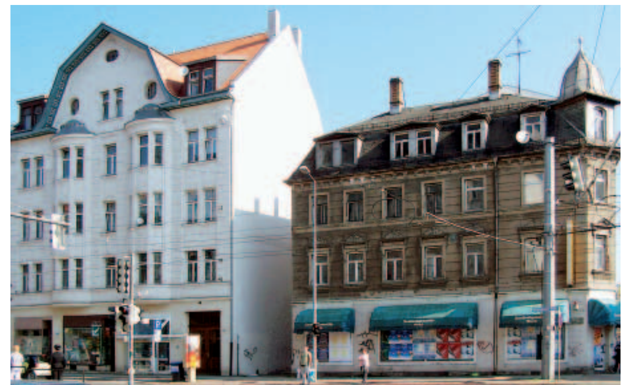
5 Stadtsanierung in Leipzig-Gohlis
