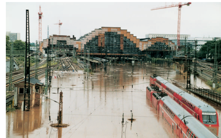
M2 Überfluteter Hauptbahnhof von Dresden Mitte August 2002
