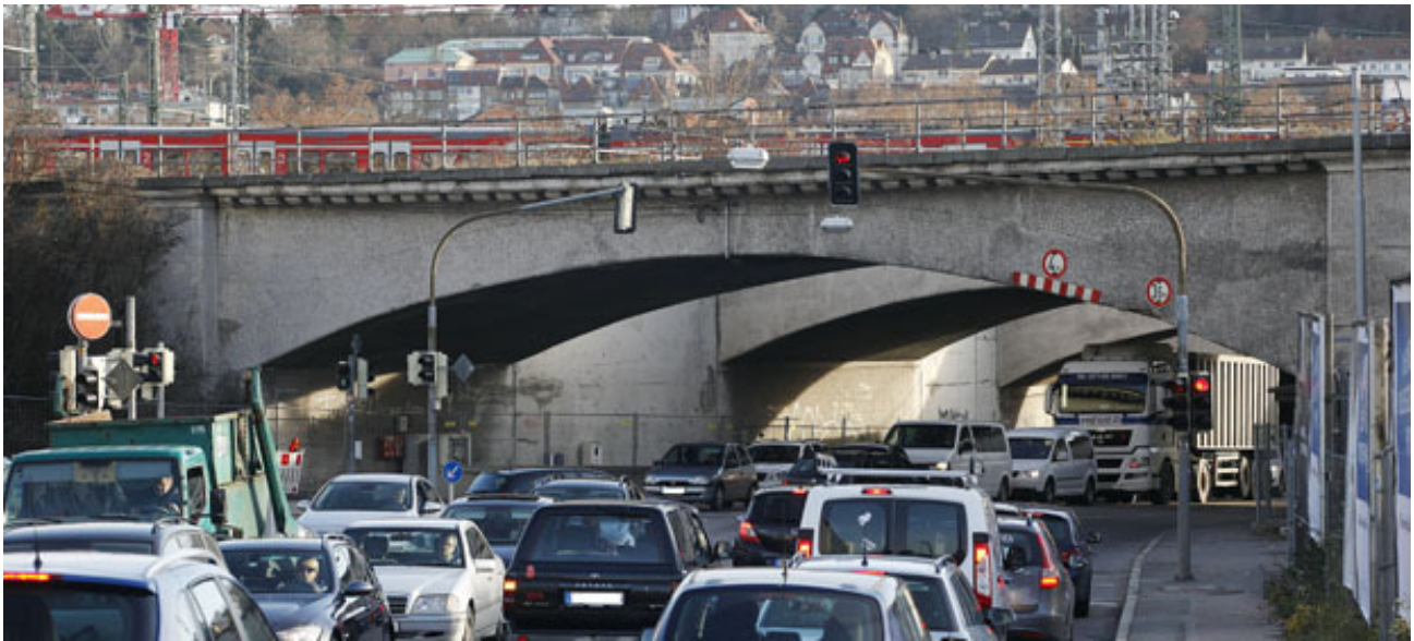
Hauptverkehrszeit in der Wolframstraße (Quelle: http://newsroom.stuttgart.de/aktuelles/detail/4ee5e0dd7321444a07000004/wolframstra-e-zwei-bruecken-werden-abgerissen )
