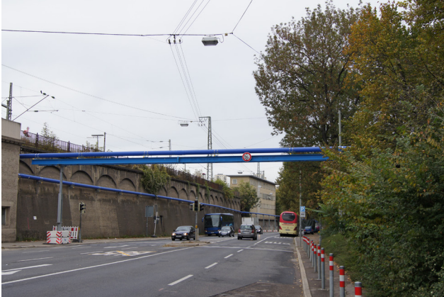
Verlegte Röhre für das Grundwassermanagement (Rosenthal 2011)
