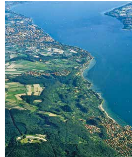
3 Bodensee Wasserwerk Sipplingen
