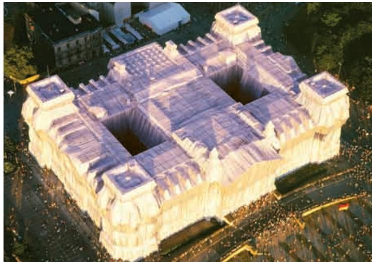
Die Grundfläche des Reichstages ist ca.  $137\text{ m}$  lang und ca.  $104\text{ m}$  breit. Die Ecktürme haben eine Höhe von  $46\text{ m}$ . Es wurden über  $100\,000\text{ m}^2$  feuerfestes Polypropylengewebe und  $15\,600\text{ m}$  Seil verarbeitet. Bei der Montage wurden  $90$  Kletterer benötigt.
