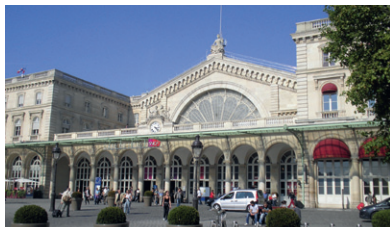
la gare de l'Est
