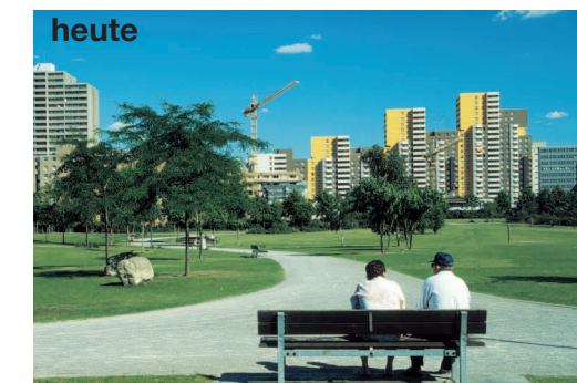
Umgestaltung der Elbe-Allee zugunsten des Olof-Palme-Parks im Rahmen der ersten Stufe des „Ergänzungsprogramms Chorweiler“
