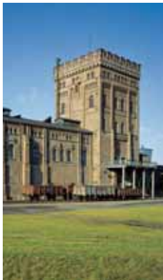
Malakoffturm mit Maschinenhaus der ehemaligen Zeche Hannover in Bochum-Hordel
