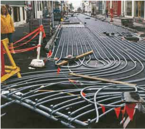
M 3.7 Einbau einer Bodenheizung in eine Hauptstraße von Reykjavik
