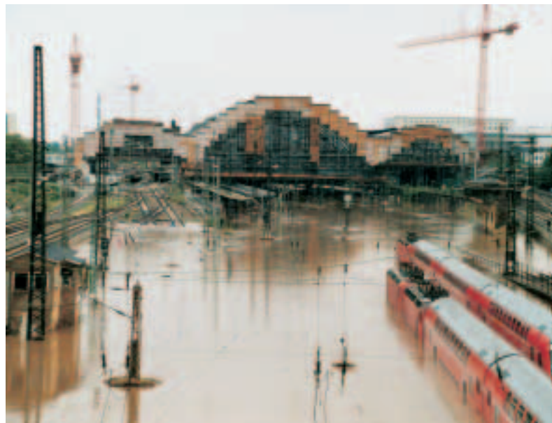
1 Dresdner Hauptbahnhof im August 2002
