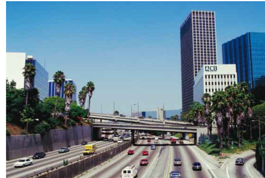
4 Nördlicher Harbour Freeway
