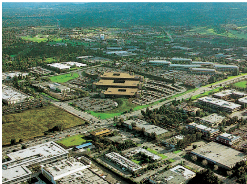
Halbleiterzentrum Silicon Valley
