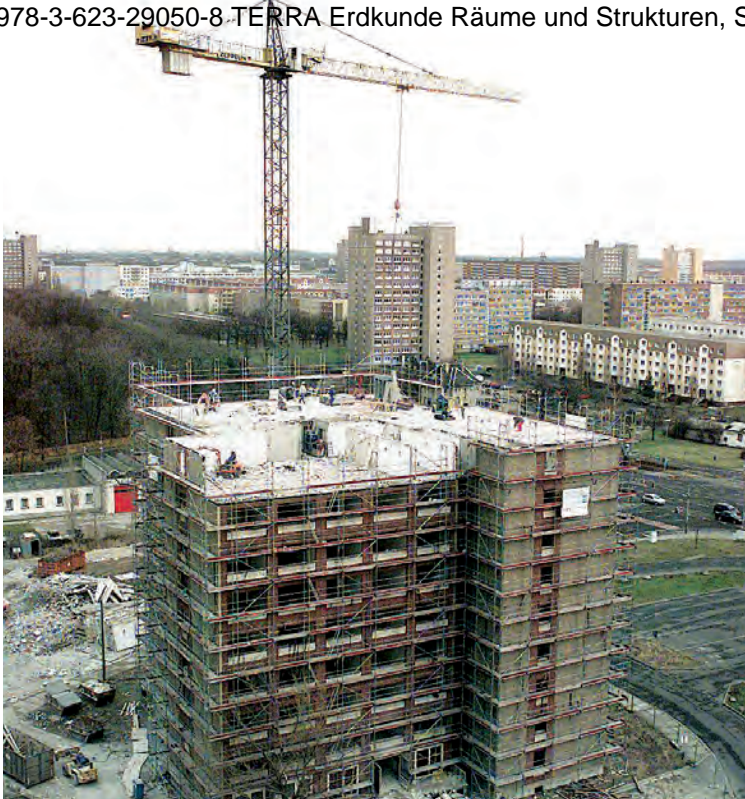
Leipzig-Grünau 2004 – Rückbau eines Plattenbaus
