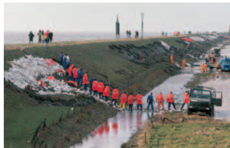
3 Deich bei Dagebüll nach der Sturmflut am 28. Februar 1990
