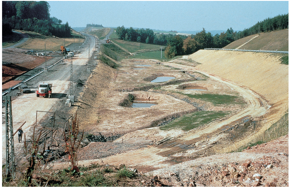
Bahnstrecke im Kallbachtal während des Baus
